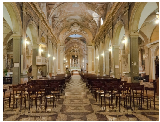
Basilica di Santa Maria Maggiore, Bo – restauro architettonico di interni ed esterni, riparazione con rafforzamento locale e progetto illuminotecnico.
